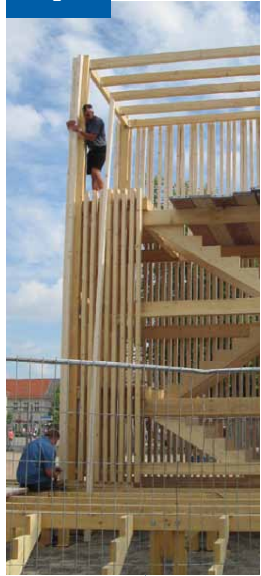
Im Juli 2010: Zimmermansarbeit
